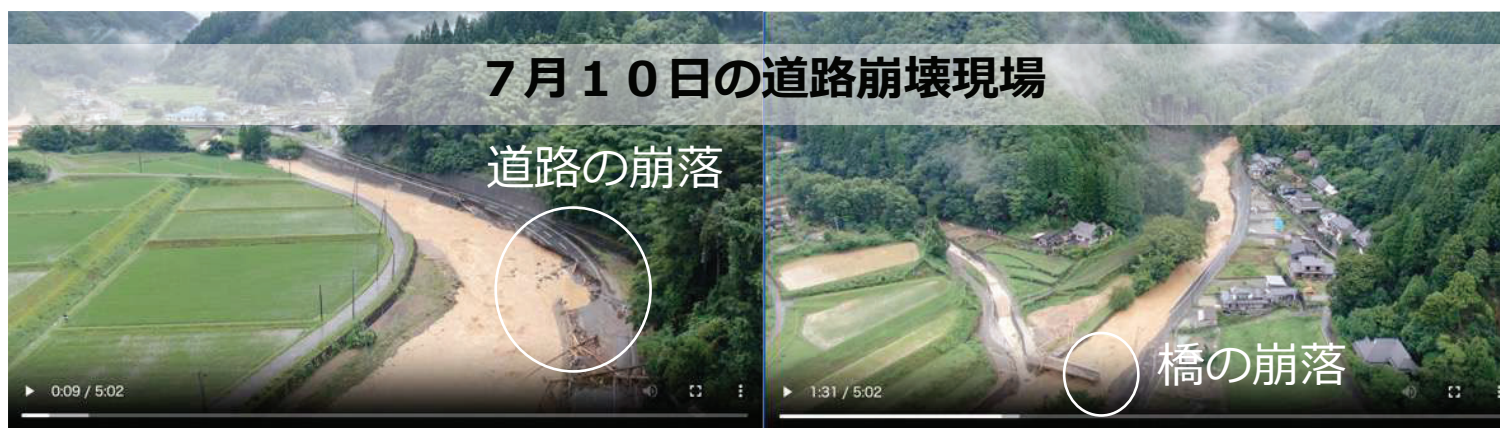
7月10日14時には道路崩壊による孤立集落の状況把握
